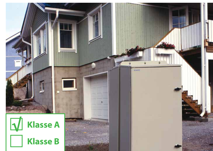
Ikke engang vanlige koblingstavler har hurtigvirkende sikringer, så bare klasse A-klemmer kan brukes.
